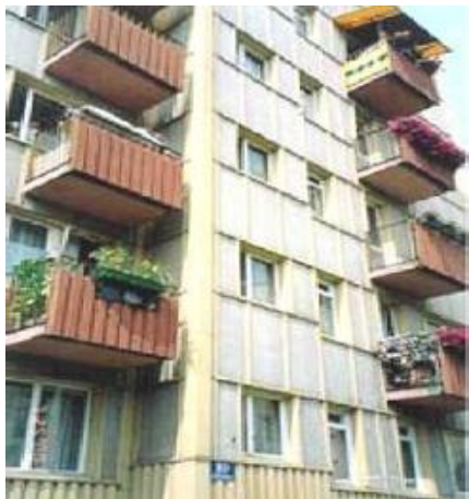
Zdjęcie 10 Elewacja wykonana z płyt azbestowo-cementowych płaskich
