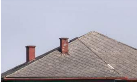
Zdjęcie 8 Płyty płaskie prasowane tzw. szablony lub płyty „karo” (PN-66/B-14040)
