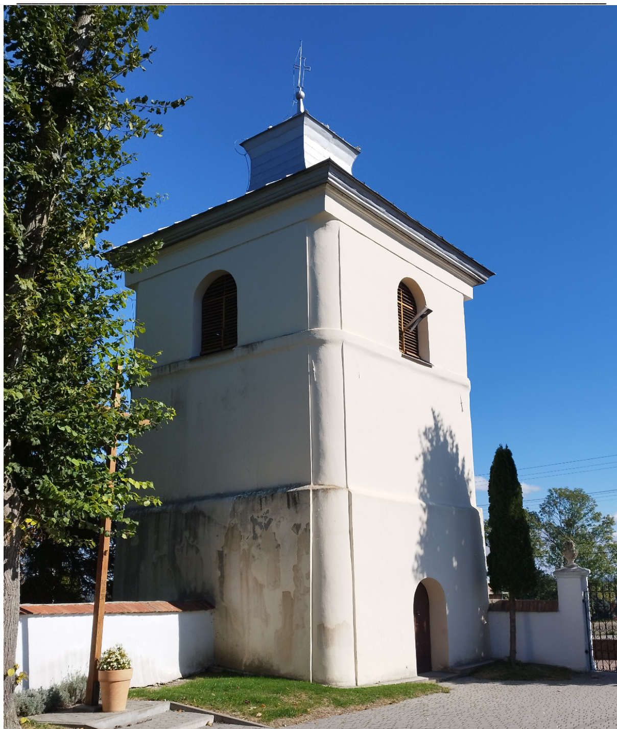
Dzwonnica widziana wewnątrz ogrodzenia
