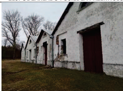
Pudlingarnia – hala główna zakładu
