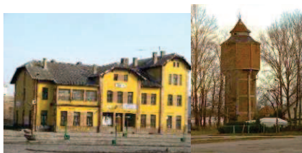
Dworzec i wieża ciśnienia, ul. Sportowa w Końskich
