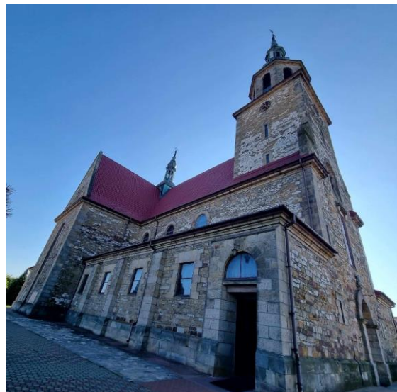
Fotografia 5. Widok na kościół pw. Podwyższenia Krzyża Świętego.
