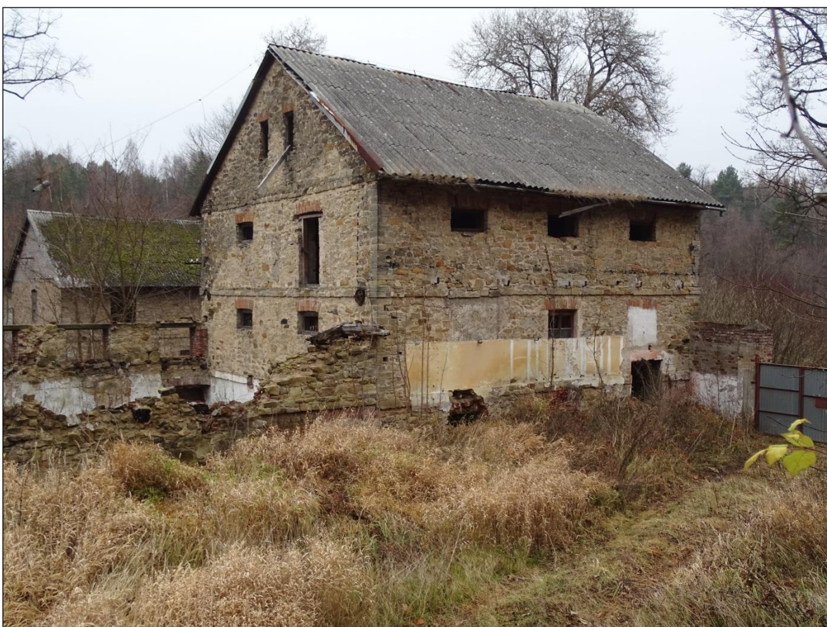
Młyn – magazyn techniczny
