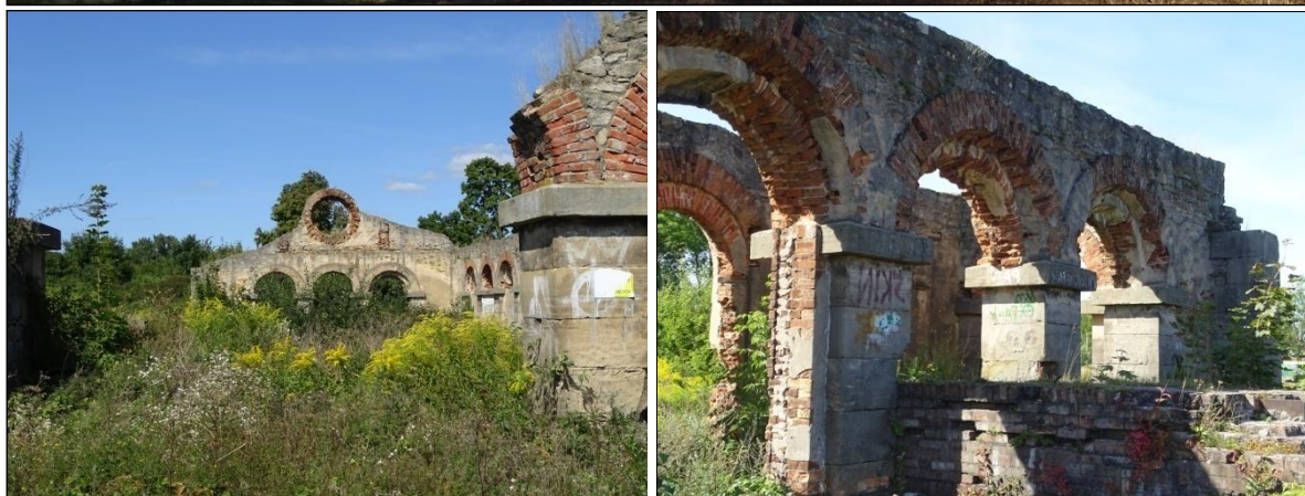
Ruiny hali produkcyjnej zakładu walcowniczego
