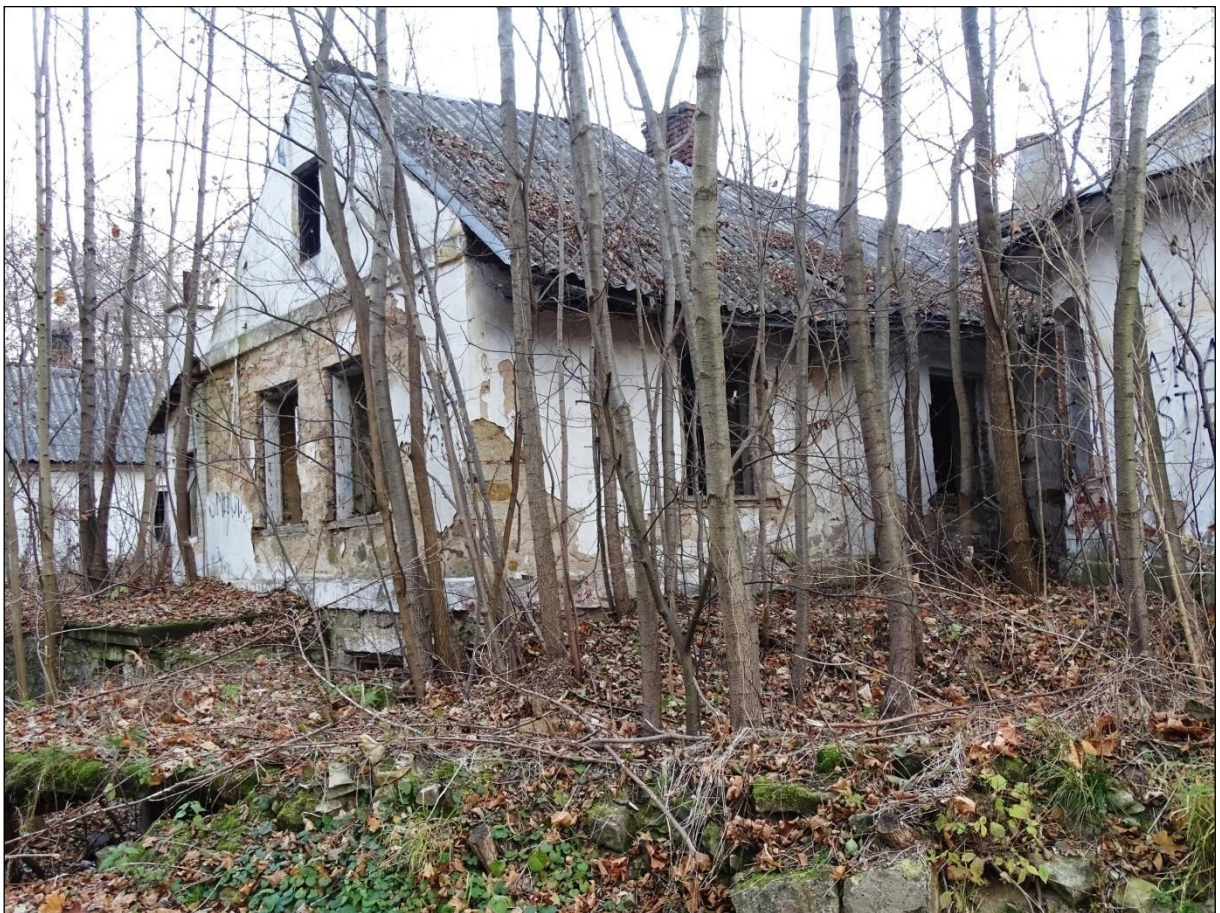
Ruiny budynku administracyjno-mieszkalnego
