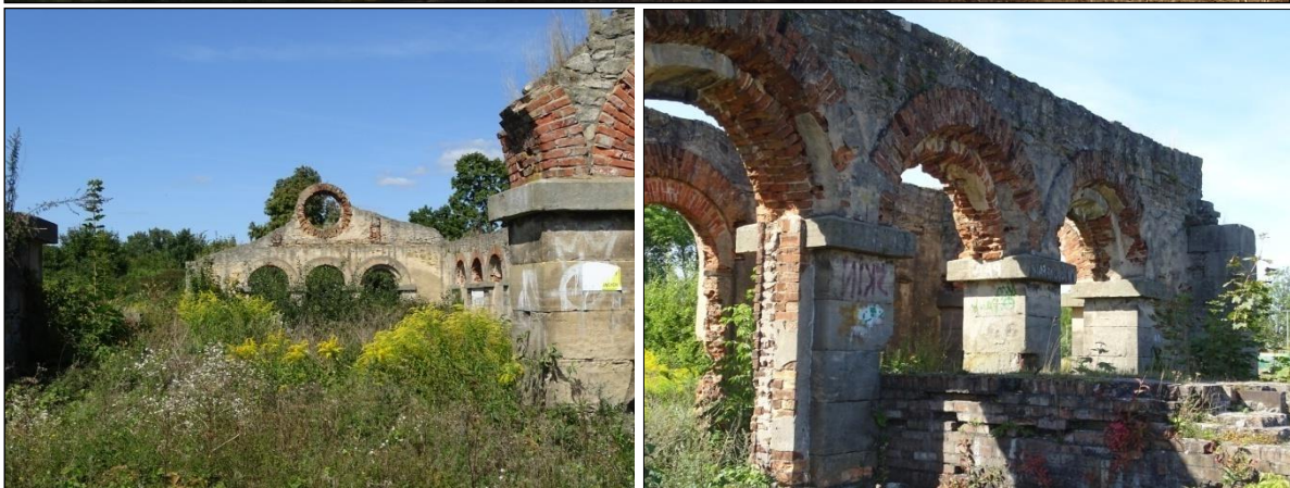
Ruiny hali produkcyjnej zakładu walcowniczego
