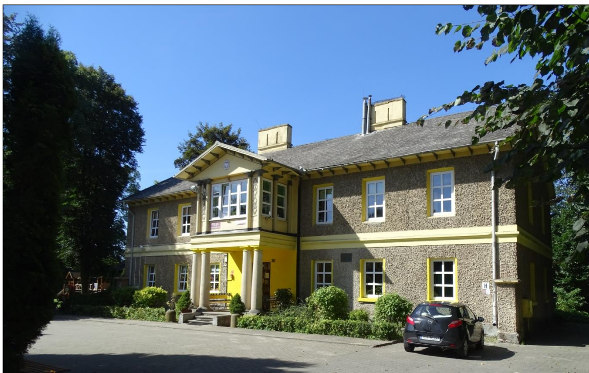
Budynek dyrekcji (zarządu) zakładu, ob. szkoła
