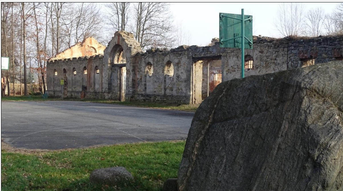
Magazyn, dawna stajnia
