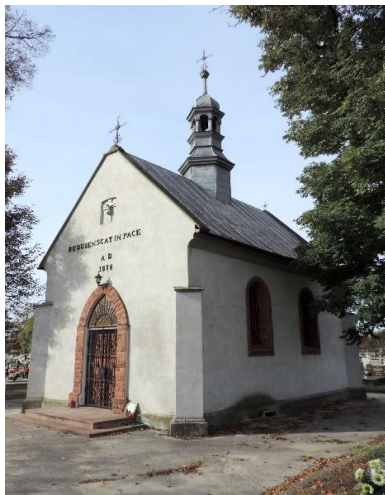
Zdjęcie nr 20. Kaplica cmentarna na cmentarzu parafialnym, Szaniec
