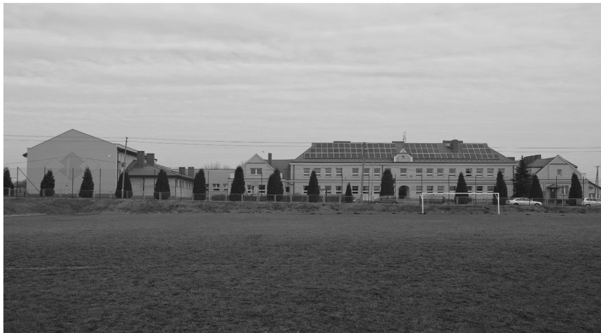
Widok na Szkołę Podstawową we Włostowie od strony boiska sportowego
