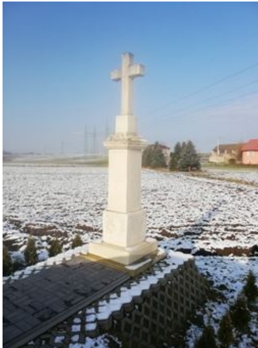
56) Krzyż murowany zlokalizowany po lewej stronie na łuku drogi powiatowej DP0743T w miejscowości Stodoly-Kolonie w kierunku miejscowości Grochocice
