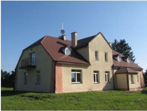
Zdjęcie 8. Dwór w Głazowie
