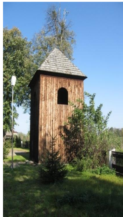
Zdjęcie 4. Dzwonnica przy kościele w Kleczanowie
