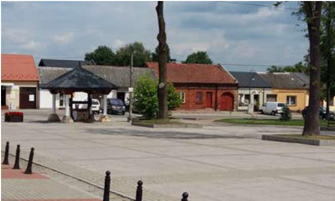
Rynek – północno-wschodnia pierzeja (pozostałości najstarszej zabudowy mieszkalnej)
