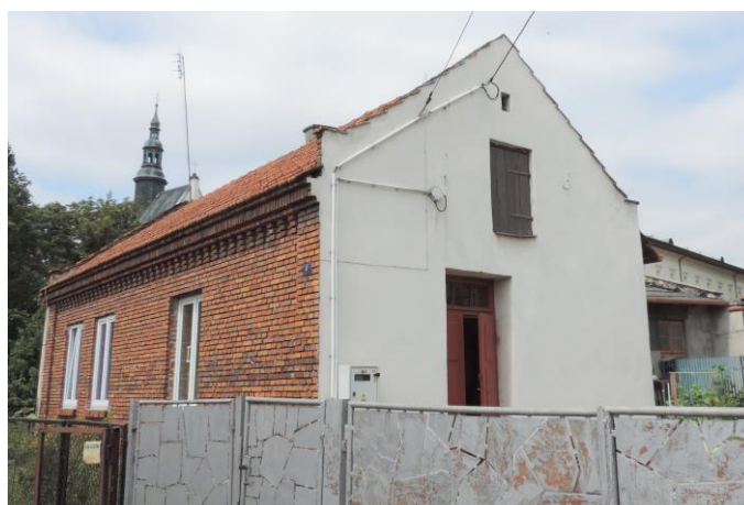
Fot. 4. Jednorodzinny budynek mieszkalny w Pińczowie na ul. Górnej z końca XIX w. – przykład nielicznego budownictwa ceglanego
