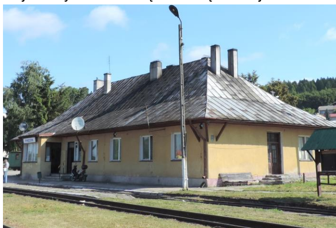
Fot. 5. Budynek dworca kolei wąskotorowej z 1926 r. w Pińczowie
