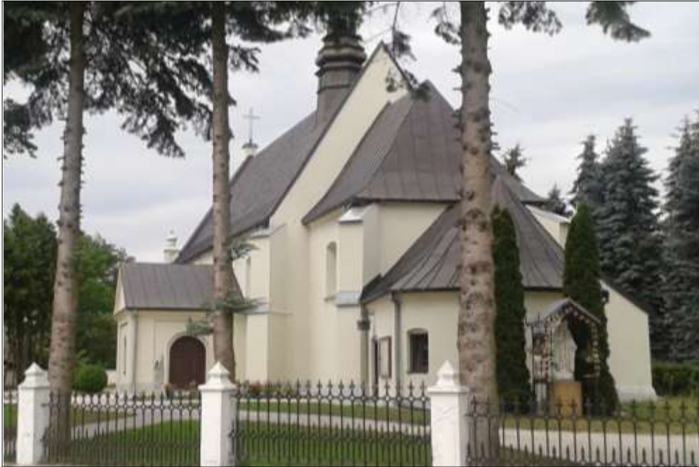
Widok ogólny od strony drogi powiatowe
