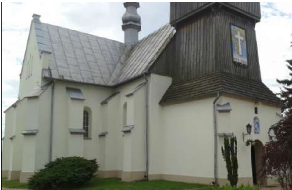
Elewacja od strony półn. - zach.
