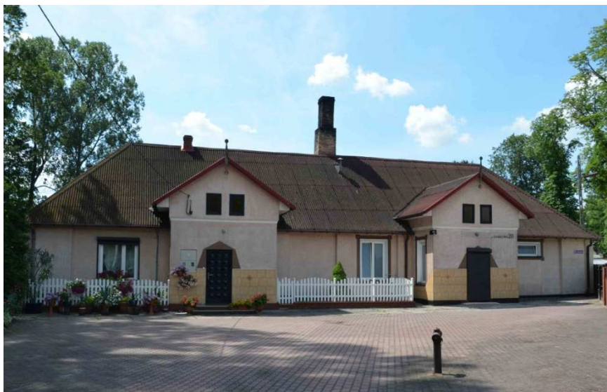
Fot. 7. Fałków. Dawna oficyna w zespole dworskim, widok od strony wsch. (fot. J. Nawrot-Bukowiec).
