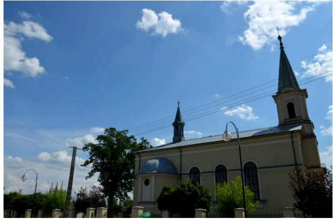
Fot. 2. Czermno. Kościół p.w. Nawiedzenia NMP i św. Mikołaja, widok od strony płn. (fot. J. Nawrot-Bukowiec).
