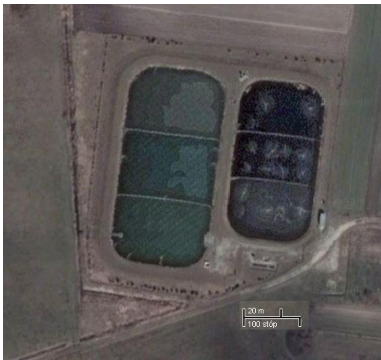
Fot. 1. Gmina Stopnica. Oczyszczalnia ścieków typu LEMNA (Fot Gogle Maps).
