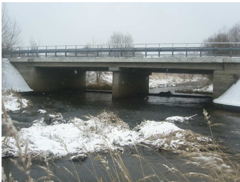
Most przystosowany do utworzenia zbiornika wodnego
